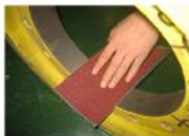
图 83 清理曳引轮接面
